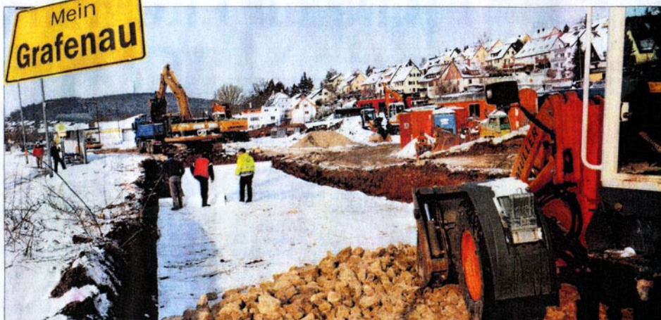
Die schweren Maschinen sind angerückt. Am Döffinger Ortseingang soll das neue Herz Grafenaus schlagen.
