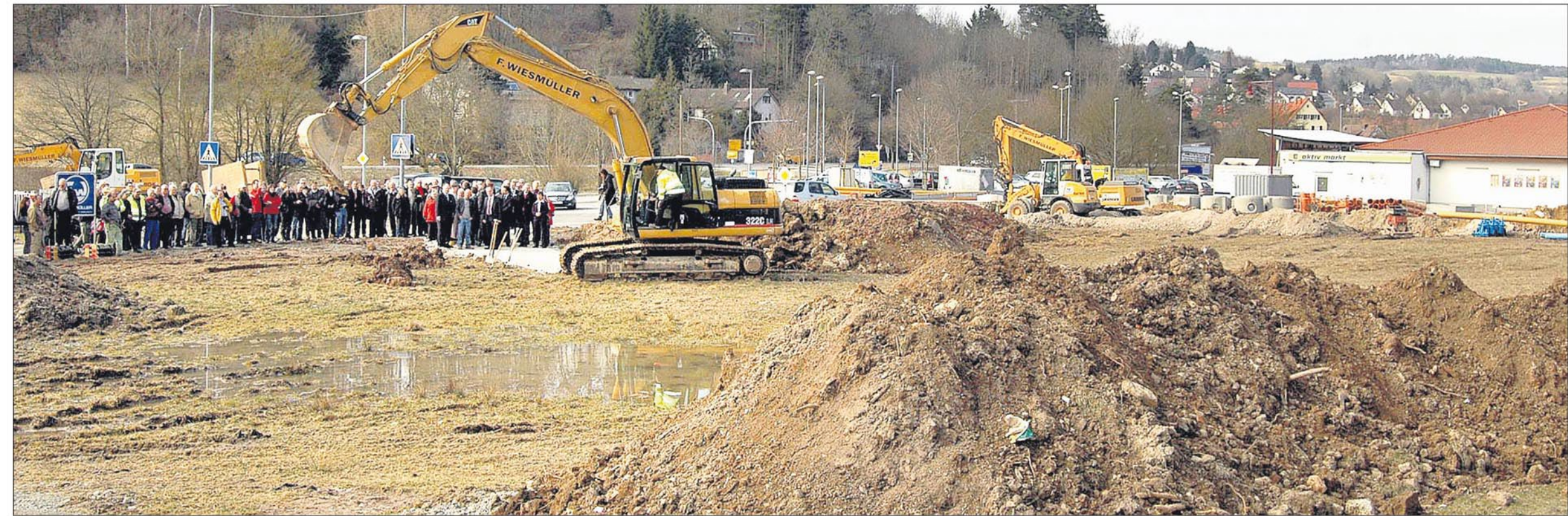
Baggerfahren macht auch Minister Ernst Pfister Spaß. Der Baggerführer musste beim Betätigen der Hebel für die Schaufel allerdings etwas nachhelfen
